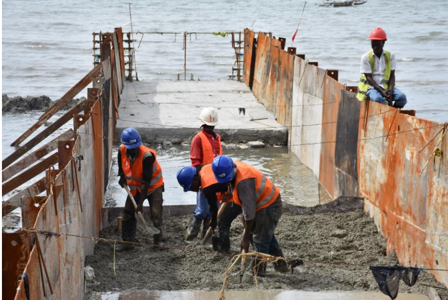
Picha ya ujenzi wa mfereji wa maji ya mvua kuelekea baharini.
